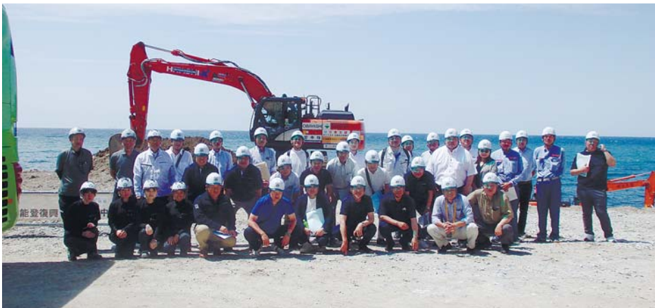
遠隔操縦のバックホーを使った輪島市曾々木地区の地すべり復旧現場も見学
